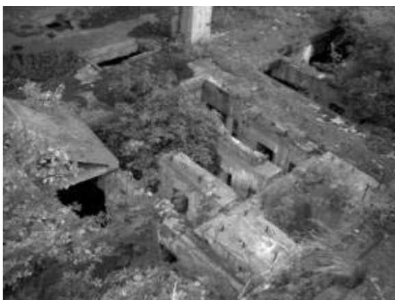
Eines von 5 Kompressor- Fundamente
