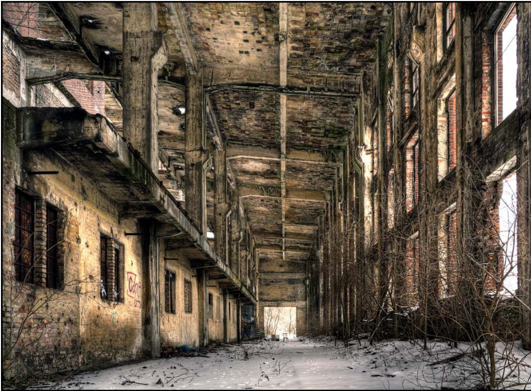
Seitenschiff, Südseite, Verladebereich, Blick nach Osten
