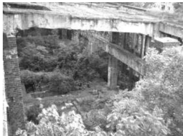
Blick in die Kompressor- Halle
